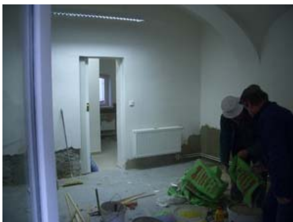
probíhající drobné stavební úpravy
